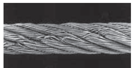
Dieses Drahtseil wurde über die Flanke einer Seilscheibe gezogen. Beachten Sie die geneigte Schadensspur.
