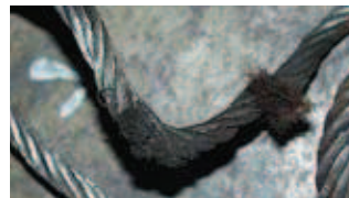
Heraustreten der Hanfseele (kein Seilverbund mehr)
