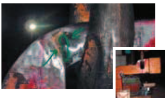
Tiefer und gefährlicher Riss in der C-Haken-Aufhängung
