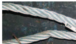
Knickstelle in der Schleufe
